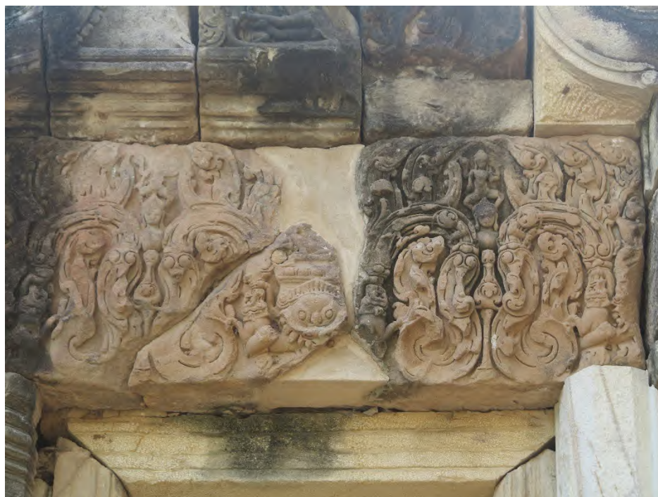
รูปที่ ๓.๑๖ ทางเข้าโคปุระทิศตะวันออก
